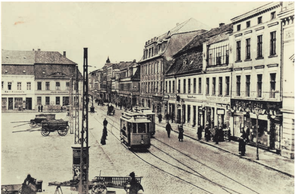
Haltestelle an der Südseite des Marktes
